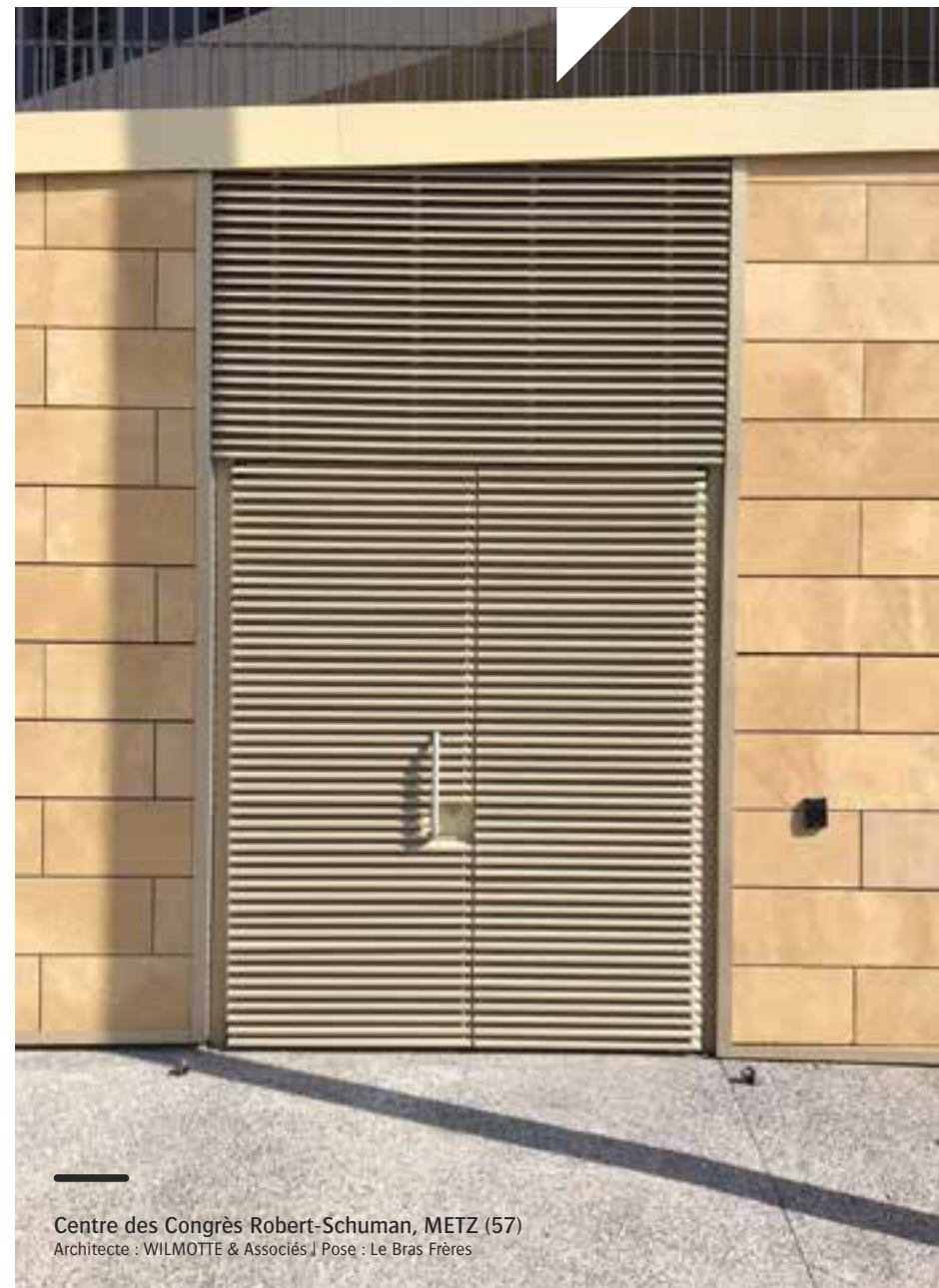
Bardage à ventelles FL340. Pose verticale sur porteurs (RAL 7024 satiné).
