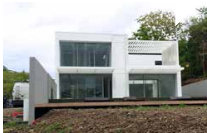
Brise-soleil à lames RL150x32 entre consoles. Pose horizontale en casquette (RAL 9010 satiné).
