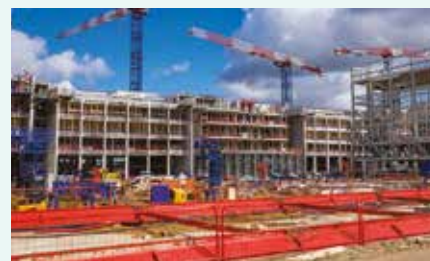
Figure 3.9 - L'ENS de Paris-Saclay en chantier. En façade, des vantaux régulent la ventilation naturelle de la plus grande partie de cet ouvrage (Renzo Piano Architecte)
