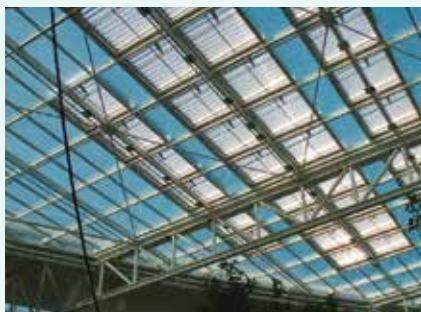
Figure 3.3 - Les verrières permettent de réaliser des volumes tampons profitables en termes thermiques.
