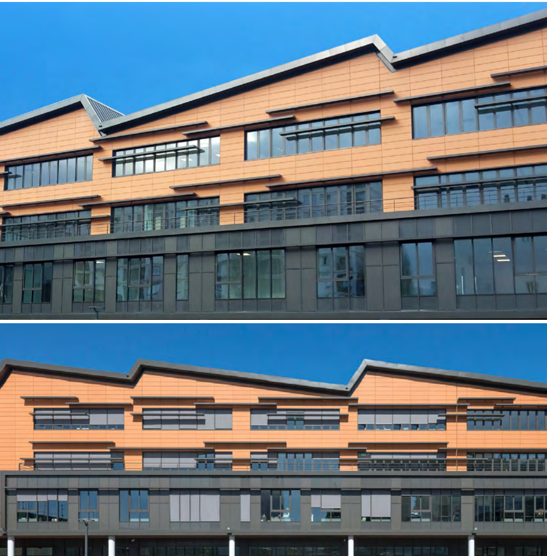
Collège Gisèle-Halimi, AUBERVILLIERS (93) Architecte : Alcyone Architecture | Pose : SMAC 95 - SAS Leuillet
